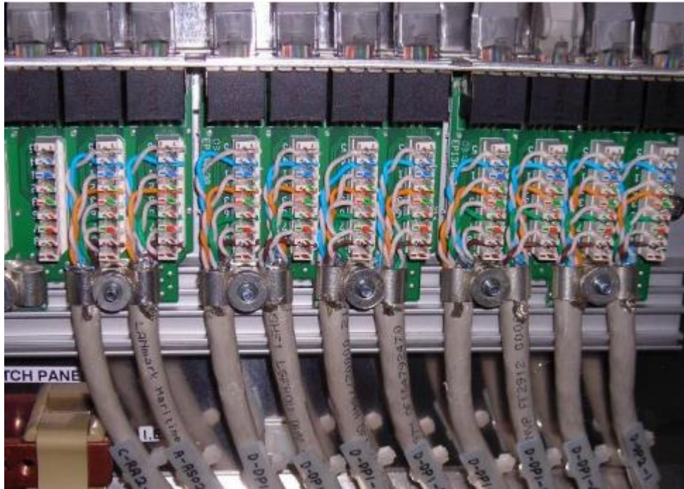
圖 8: 網路線正確的接線方式
